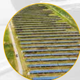
manutenção em usinas
